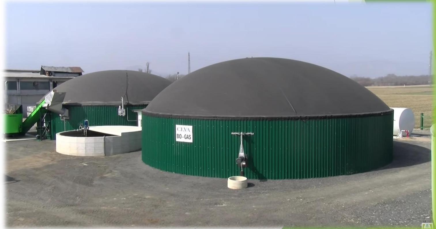
Tutto il materiale viene confluito nel **digestore 1** e questo collabora con il **digestore 2** in entrambi avviene la fermentazione e la conseguente produzione naturale di GAS.
